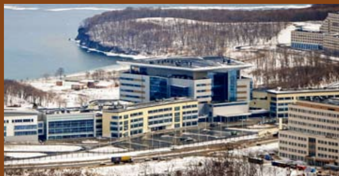
Кампус Дальневосточного федерального университета (о. Русский) Сроки строительства: 2009–2012 гг. Стоимость: 72 млрд рублей
